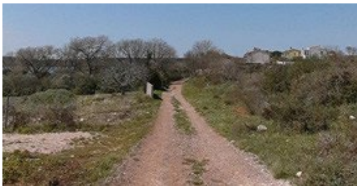
Nezpevněný / šterkový povrch na úseku trasy EuroVelo 8, Chorvatsko [13]
